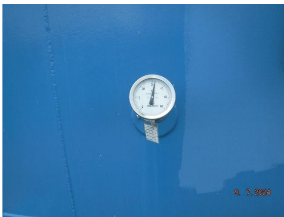
รูปที่ 2.2.1-3 เทอร์โมมิเตอร์ วัดอุณหภูมิสินค้าในแท้งค์
