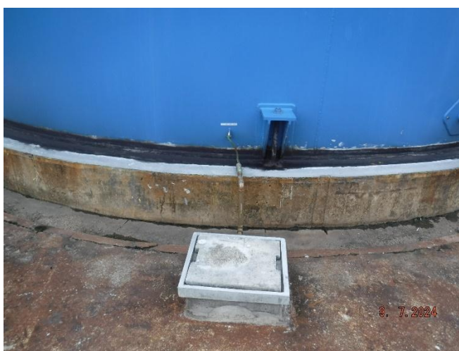
รูปที่ 2.2.1-7 สายดินของตัวถัง
