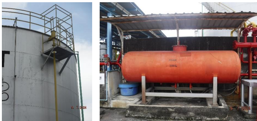
รูปที่ 2.2.1-4 Air Foam Chamber (หัวต่อท่อสีแดง)
