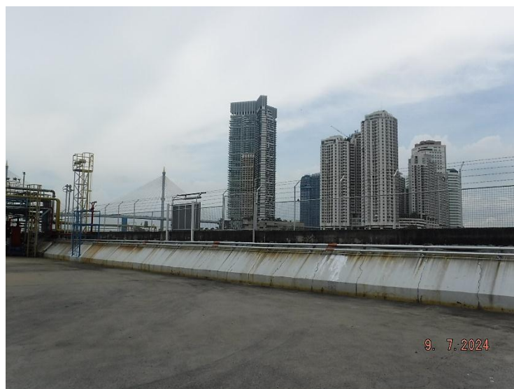
รูปที่ 2.2.2-1 กำแพงคอนกรีตเสริมเหล็กที่รอบท่าเรือ
